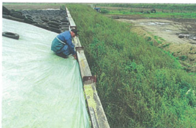
Abb. 14: Einstecken der Silofolie am Silorand
