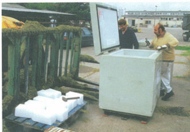
Abb. 7: Das Trockeneis wird in Thermobehältern zum Silo gebracht
